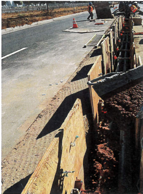
Doty Bros pouring slurry over conduits at San Fernando Blvd.
